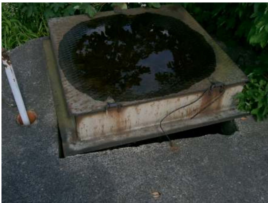
Fot. nr 3 Wyłaz rewizyjny zbiornika retencyjnego
