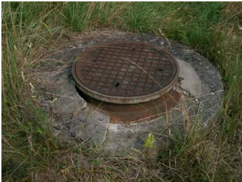
Fot. nr 2 Studzienka rewizyjna kanalizacji deszczowej
