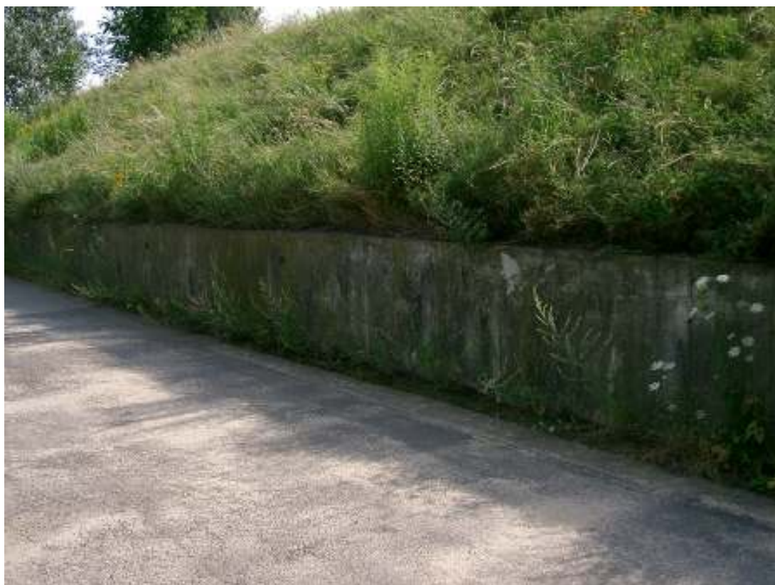
Fot. nr 8 Mur oporowy zabezpieczający skarpe przed osuwaniem
