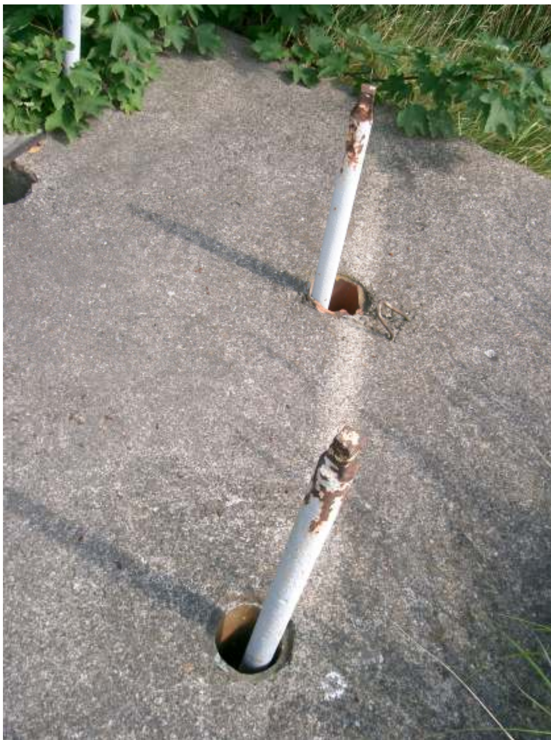
Fot. nr 7 Wystający pręt do regulacji zasuw wewnątrz zbiornika.
