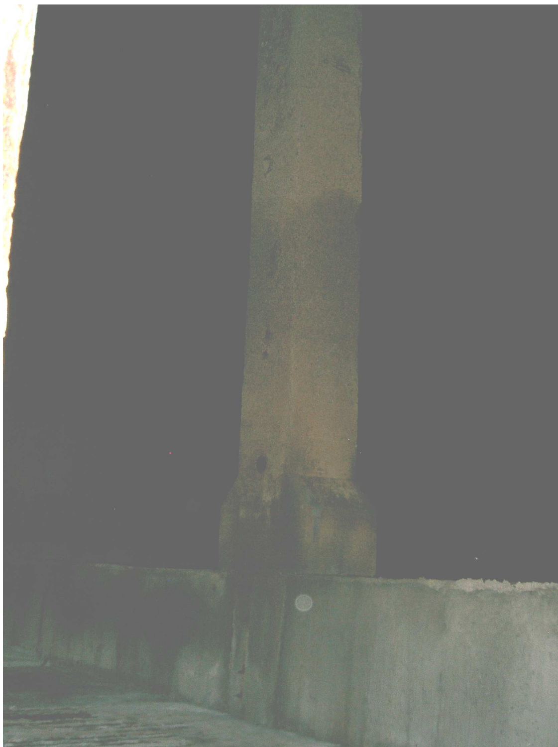
Fot. nr 5 Widok wnętrza zbiornika. Słupy żelbetowe podpierające strop zbiornika
