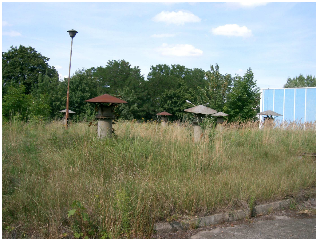
Fot. nr 1 Ogólny widok nasypu nad zbiornikami retencyjnymi z widocznymi odpowietrznikami. Po prawej stronie widoczny fragment hali magazynowej.
