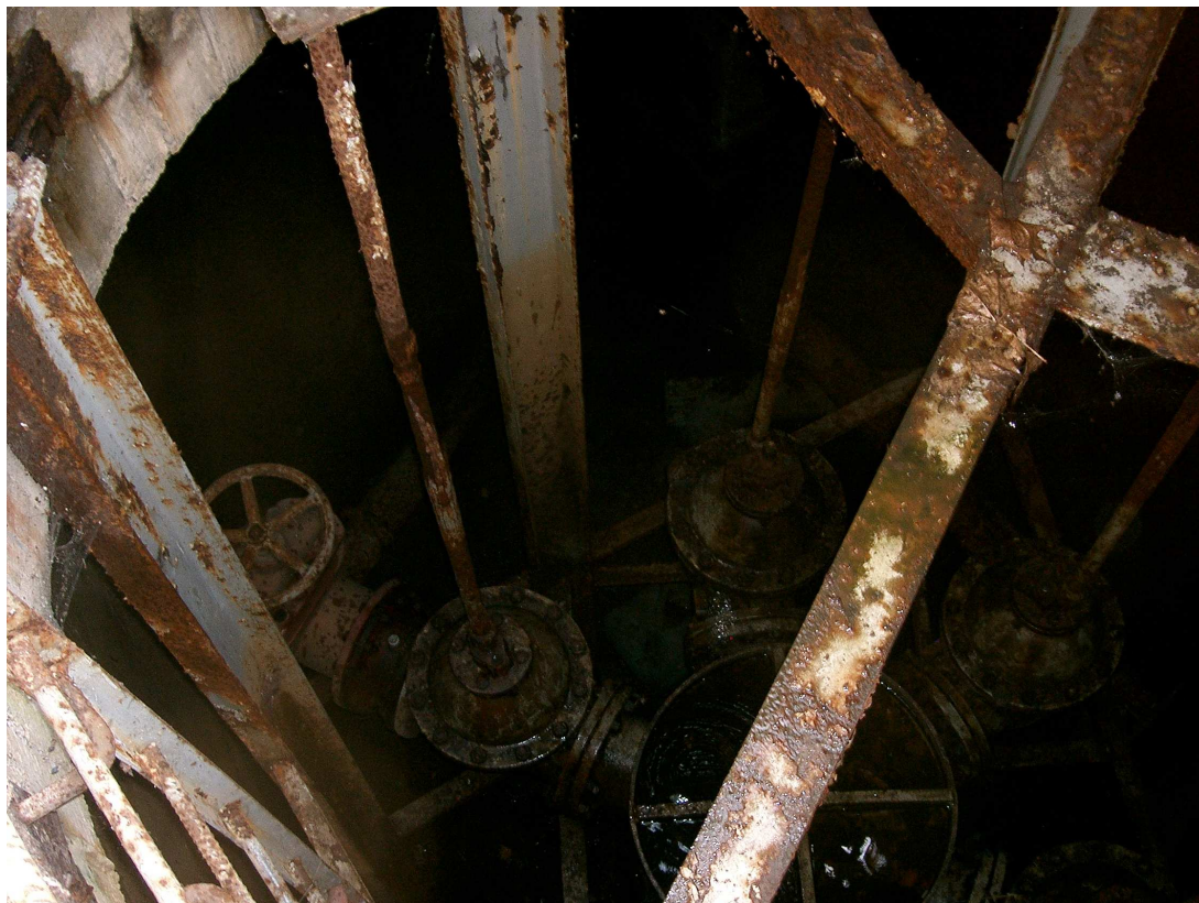
Fot. nr 4 Widok wnętrza zbiornika. Instalacja wewnętrzna oraz konstrukcje pomocnicze jak drabina, konstrukcje wsporcze itp.
