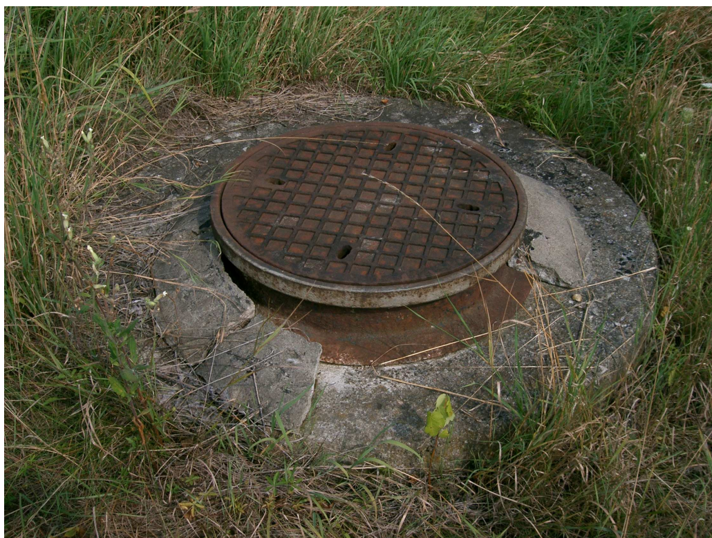
Fot. nr 2 Studzienka rewizyjna kanalizacji deszczowej
