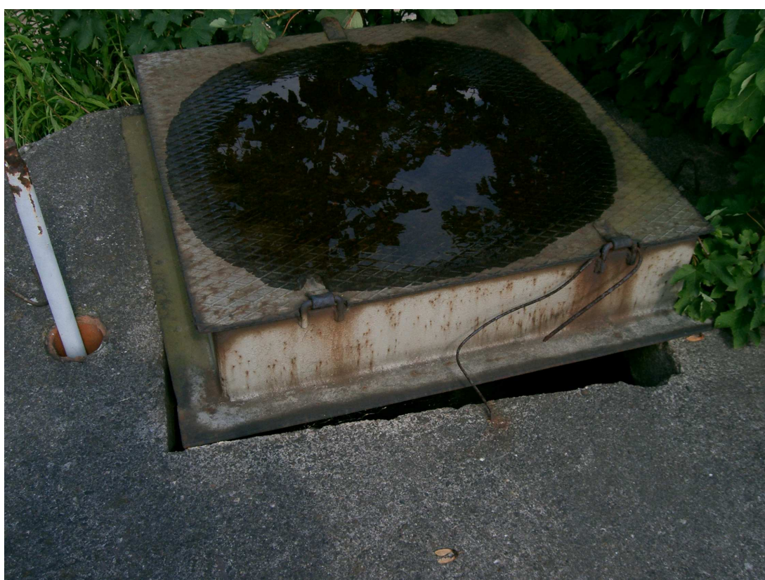
Fot. nr 3 Wyłaz rewizyjny zbiornika retencyjnego
