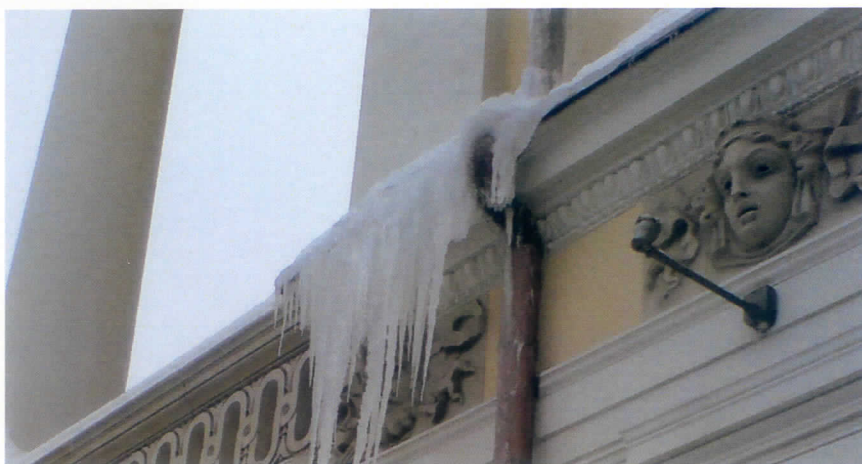
Fot. 8, 9 i 10 Ilustracja skutków zamarznięcia koryt i rur spustowych - przelewanie się wody przez górną krawędź koryt i spływanie po elewacji, usuwanie nawisów z podnośnika koszowego
