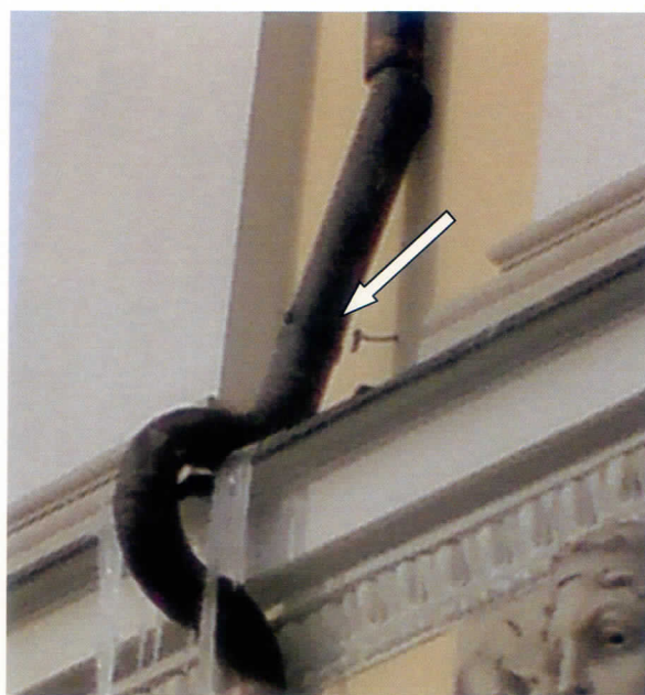
Fot. 16 i 17 Zniszczenia spowodowane oblodzeniem - oderwana lampa elewacyjna i rura spustowa (widoczny pęknięty hak mocowania), na południowej elewacji budynku opery
