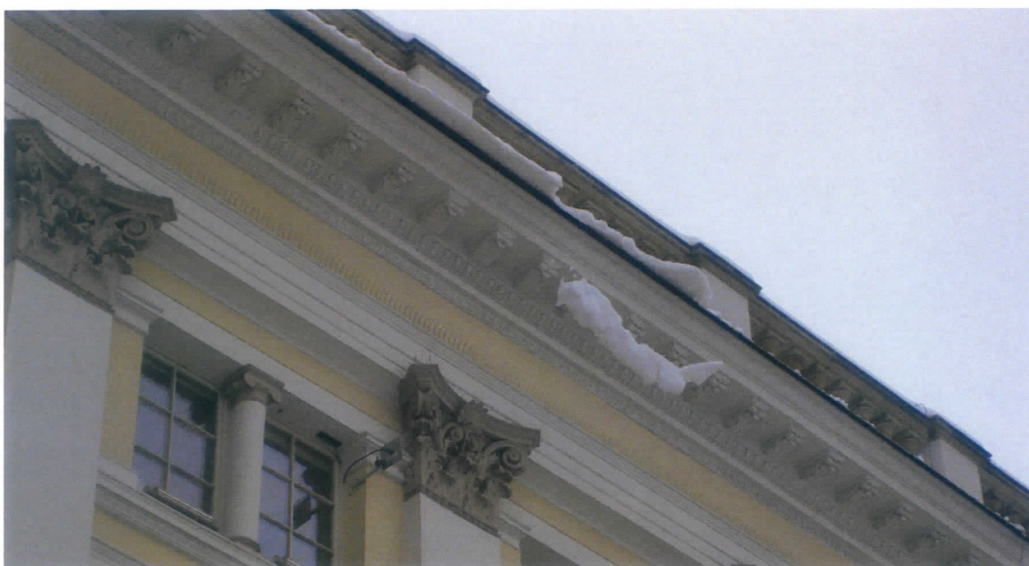
Fot. 12 Kontrolowane zrzucanie śniegu z gzymsu elewacji południowej, który po nocnych przymrozkach zamienił by się w lodowe tafle
