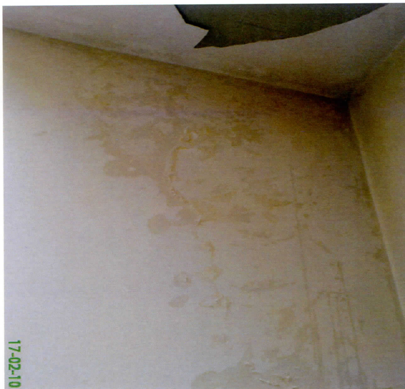
Fot. 18 Zalane sufit i ściany klatki schodowej IV P, na skutek niedrożności zamrożonego przepustu przez ogniomurek (elewacja północna, narożnik zachodni)
