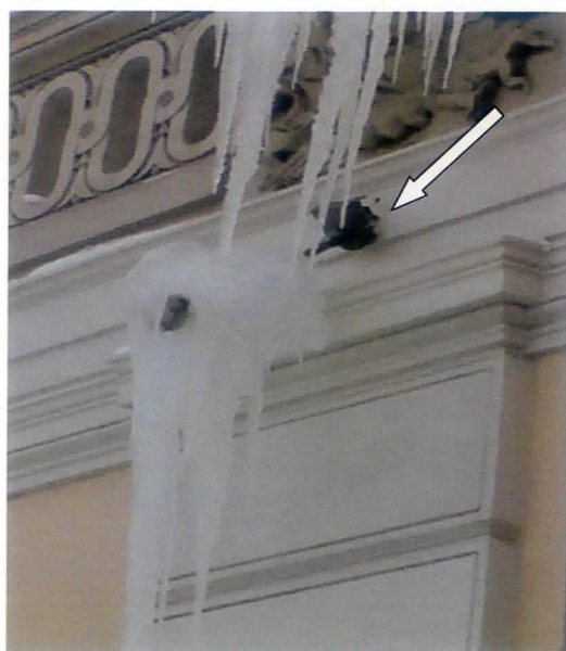
Fot. 16 i 17 Zniszczenia spowodowane oblodzeniem - oderwana lampa elewacyjna i rura spustowa (widoczny pęknięty hak mocowania), na południowej elewacji budynku opery
