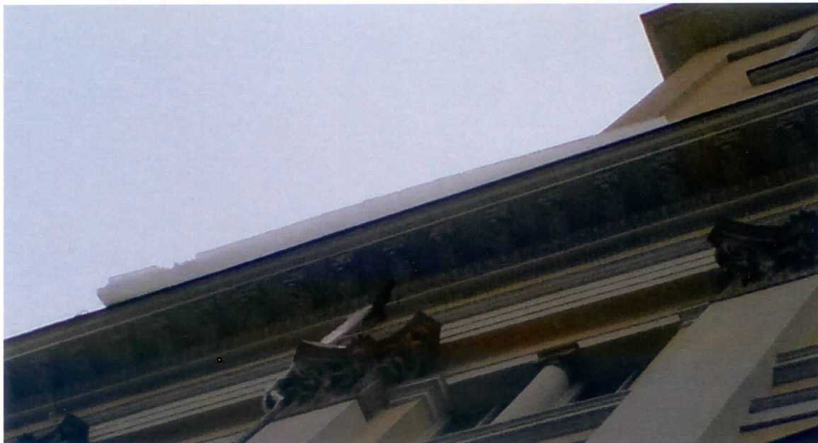
Fot. 11 Tafle zlodowaciałego śniegu zaczynają wysuwać się poza obrys gzymsu elewacji północnej
