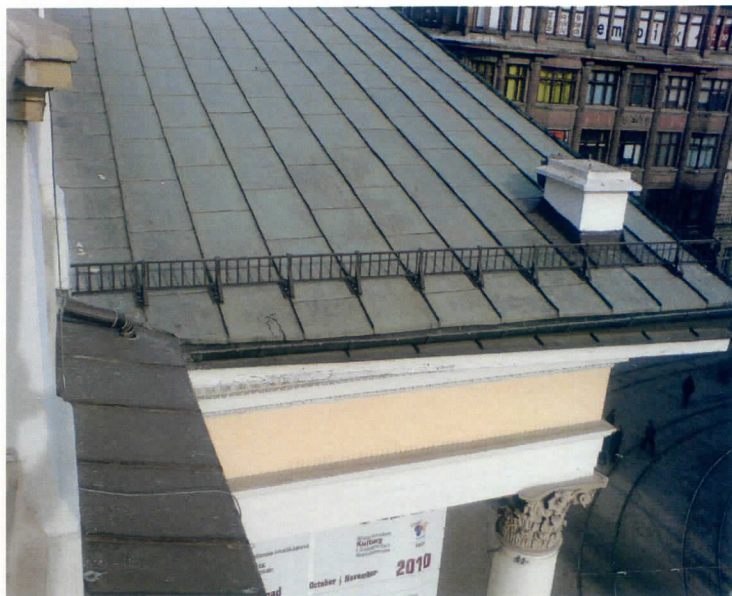
Fot. 5 i 6 Ilustracja gzymsu elewacji południowej (po lewej stronie), i fragmentu elewacji wschodniej, do dachu nad portykiem (widoczna drabinka zabezpieczająca przed zsuwaniem się śniegu)
