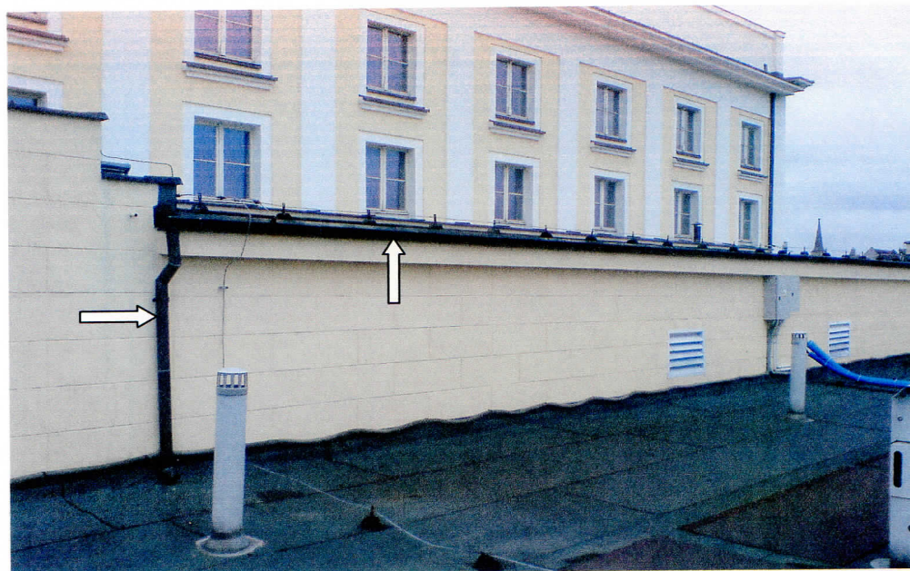
Fot. 30 Widok nadbudówki centrali klimatyzacyjnej, strzałki wskazują rurę spustową i rynnę, których oblodzenie nie stwarza zagrożeń - takie małe instalacje nie zostały zaznaczone na załączonych rysunkach elewacji
