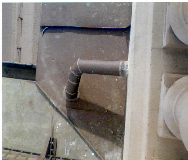
Fot. 3 i 4 Ilustracja sposobu przeprowadzenia instalacji przez ogniomurki i gzymsy przy elewacji wschodniej budynku, strzałka wskazuje miedziany kosz - początek rury spustowej
