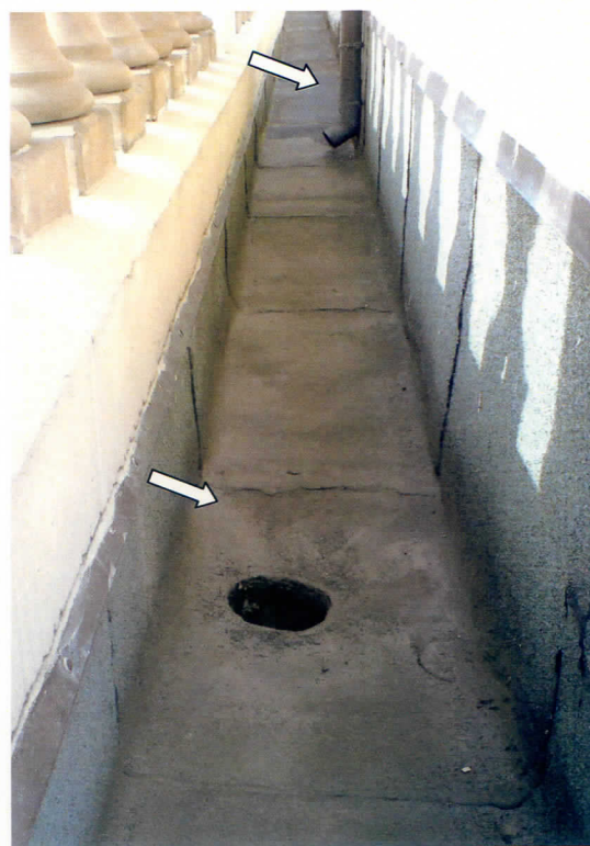
Fot. 2 Po lewej elementy instalacji odwodnienia: koryto odpływowe, przepust pod ogniomurkiem i wlot do miedzianej rury spustowej.
