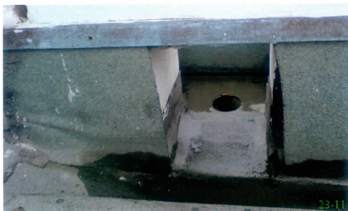
Fot. 2 Po lewej elementy instalacji odwodnienia: koryto odpływowe, przepust pod ogniomurkiem i wlot do miedzianej rury spustowej.
