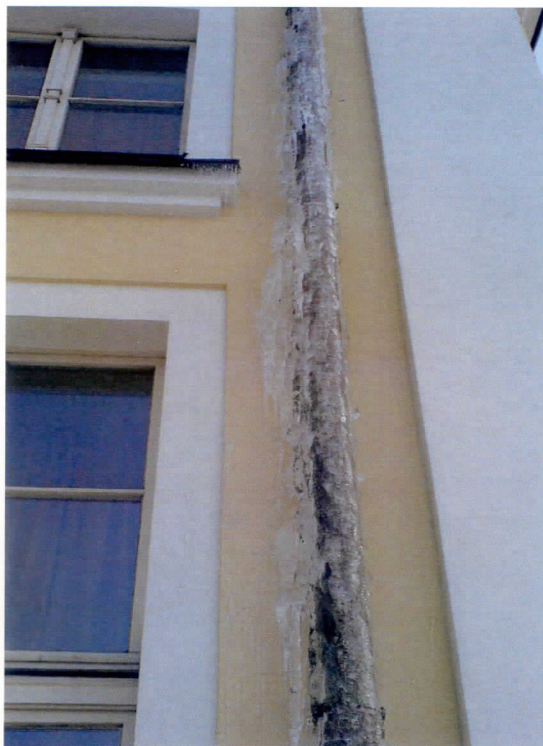
Fot. 14 i 15 Oblodzone z powodu braku instalacji grzewczej rury spustowe na zachodniej i południowej elewacji budynku opery
