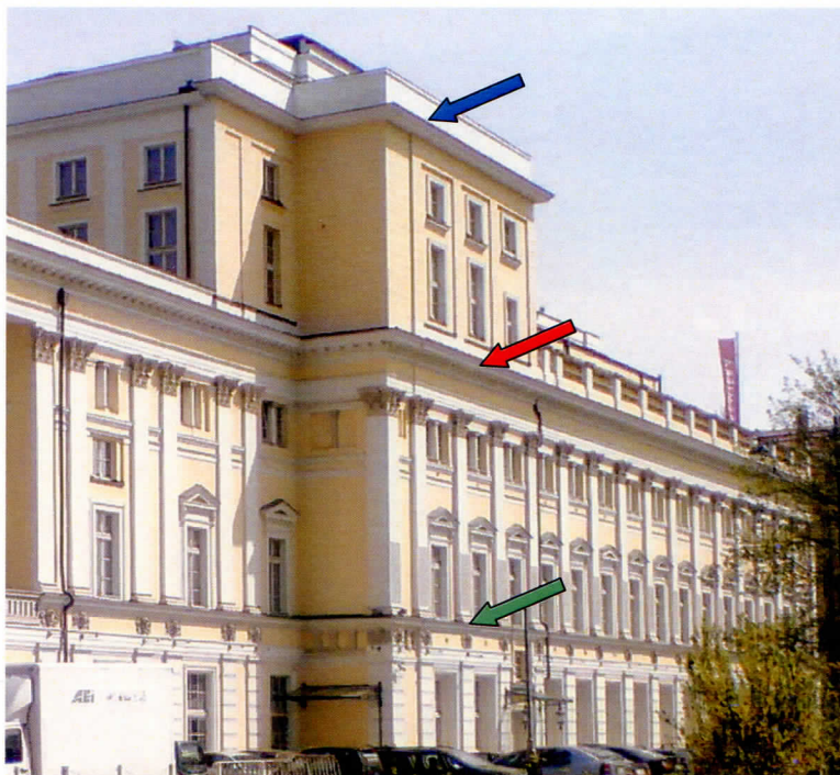
Fot. 13 Gzymsy elewacji budynku oznaczone strzałkami :
