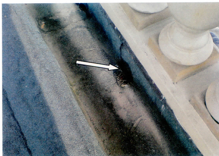
Fot. 29 Widok wyłożonego papą koryta, strzałka wskazuje wlot przepustu przez ogniomurek, ogrzewanie powinno obejmować koryto przy wlocie na odcinku minimum 1 m po obu stronach wlotu, przepust, a dalej miedzianą rurę spustową
