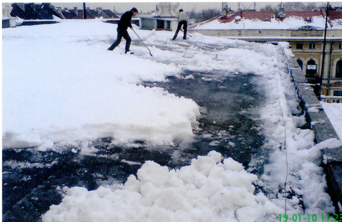
Fot. 22 Odśnieżanie dachu nad widownią - śnieg usuwa się najpierw przy krawędzi, przechodząc stopniowo w stronę kalenicy
