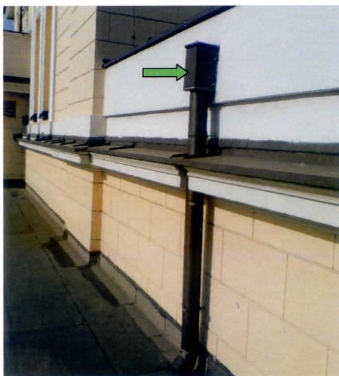
Fot. 3 i 4 Ilustracja sposobu przeprowadzenia instalacji przez ogniomurki i gzymsy przy elewacji wschodniej budynku, strzałka wskazuje miedziany kosz - początek rury spustowej
