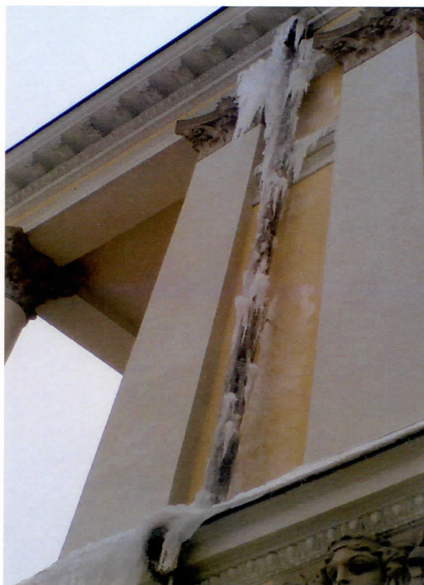
Fot. 14 i 15 Oblodzone z powodu braku instalacji grzewczej rury spustowe na zachodniej i południowej elewacji budynku opery
