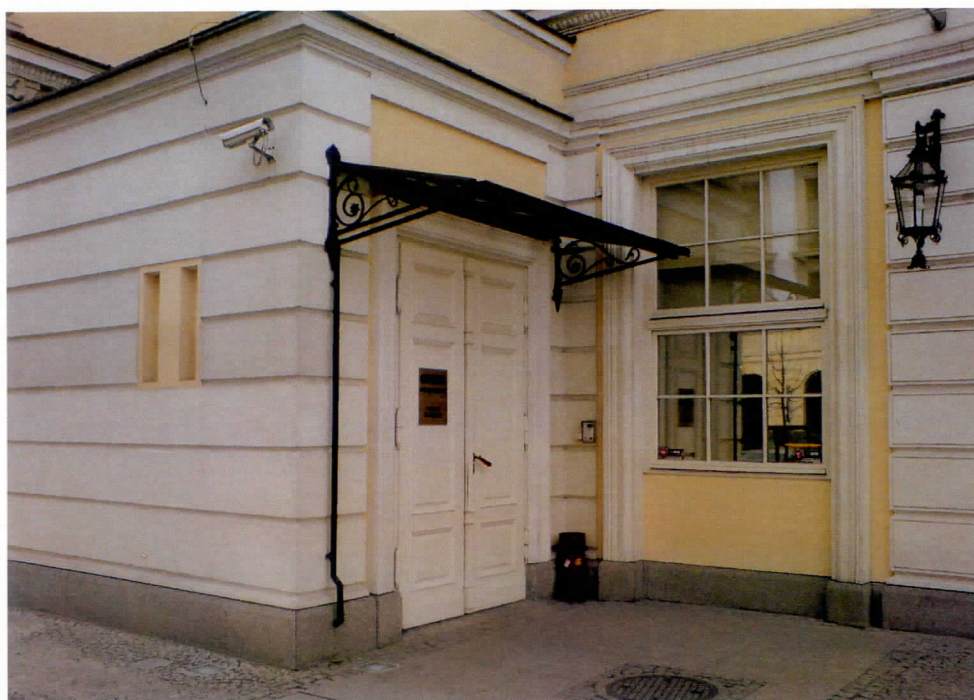
Fot. 7 Daszek ochronny nad wejściem służbowym (elewacja północna)
